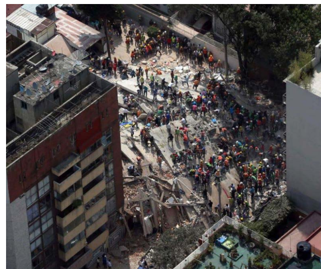
Hay otros 30 inmuebles con graves daños, 209 escuelas con afectaciones y al menos 500 que deberán ser revisados.
