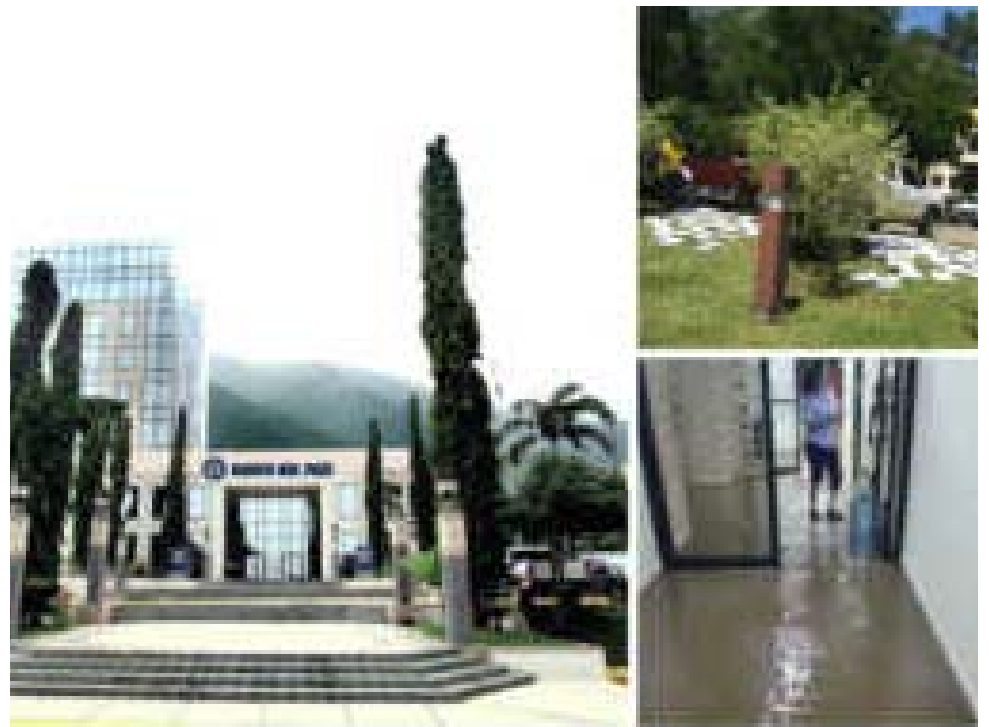
Las lluvias causaron daños en la sede principal de Banpaís.
