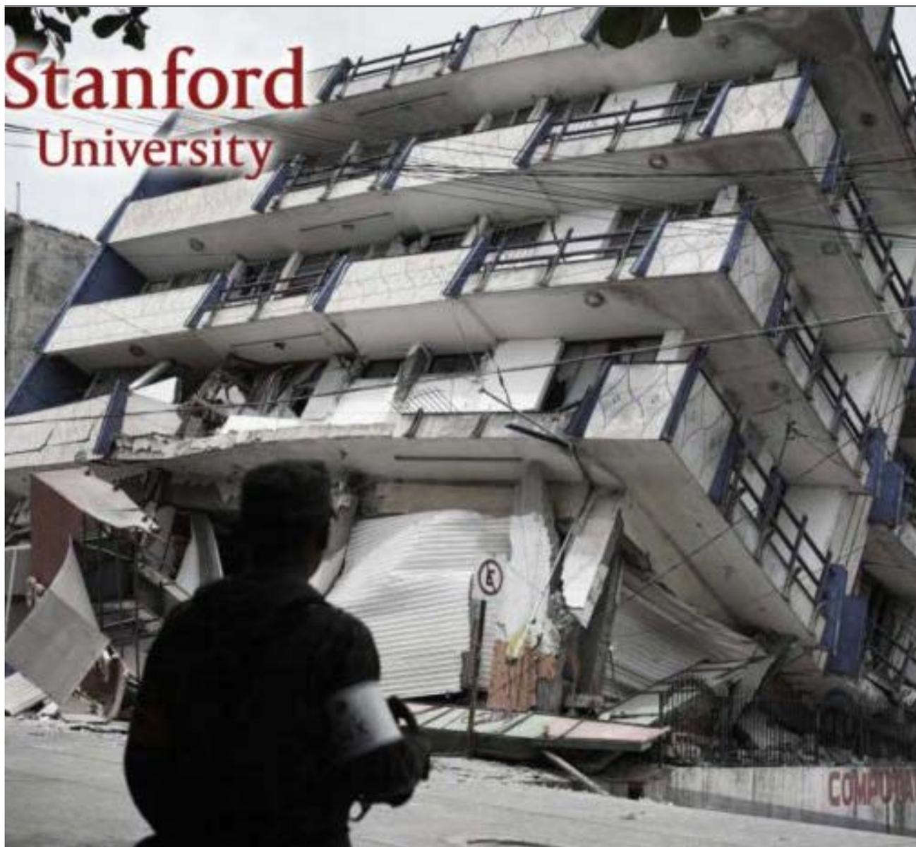
Cerca de las dos terceras partes de los 44 edificios de la Ciudad de México que se derrumbaron fueron construidos con el método de “losas planas”,
